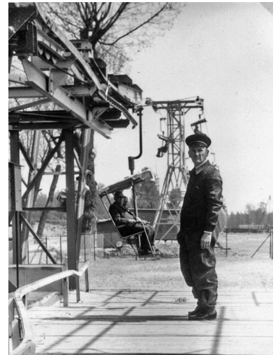
Ähnlich wie bei einem alpinen Sessellift saßen die Fahrgäste im Freien mit einem kleinen Dach. Der Seilbahnwärter half beim Einsteigen. (Foto: K. Schreck/Sammlung S. Hilkenbach)
