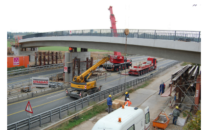
Die Mainzelbahn-Brücke über die A60 bei Marienborn ist am 17. Oktober 2015 fast fertiggestellt. (Foto: Reinhard Halbritter)
