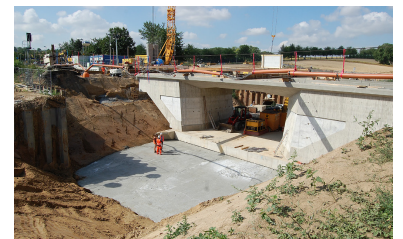
Einschieben der Unterführung der Mainzelbahn an der DB-Strecke nach Alzey am Marienborner Bahnhof am 31. Juli 2015. (Foto: Reinhard Halbritter)
