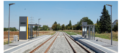
Vier Monate vor der Streckeneröffnung waren die ersten Haltestellen fertig, hier die Station Wiesenstraße in Marienborn - noch ohne Oberleitung - am 16. August 2016. (Foto: Reinhard Halbritter)
