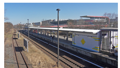
Am Verkehrsknoten und Einkaufszentrum in Marzahn fährt die RB 25 derzeit vorbei - das sollte sich ändern, um Umstiege zu reduzieren und die Attraktivität der Linie zu steigern! Der notwendige Platz ist vorhanden - schon früher hielten hier Regionalzüge. (Foto: Tom Gerlich)
