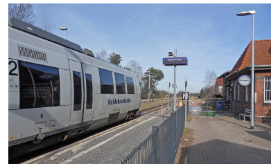
Das zweite Gleis im Bahnhof Blumberg wird für den künftig erforderlichen 30-Minuten-Takt zur Zugkreuzung gebraucht und muss beim anstehenden Umbau mit eigener Bahnsteigkante erhalten bleiben. Ohne eine Attraktivitätssteigerung wird die Straße B 158 nach ihrem Ausbau viele Fahrgäste abziehen! (Foto: Tom Gerlich)
