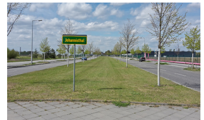
Auf dem Groß-Berliner Damm ist die Straßenbahntrasse schon als breiter Mittelstreifen vorbereitet. Das verspricht eine schnelle Planung und kurze Bauzeit. (Foto: Florian Müller)
