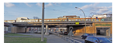
Die neue Eisenbahnbrücke in Karlshorst ist längst fertig. So langsam beginnt nun auch der Umbau der Verkehrsanlagen. Die Straßenbahn verschwenkt künftig in die Seitenlage, um einen direkten Zugang zum S-Bahnsteig zu ermöglichen. (Foto: Tom Gerlich (2016))
