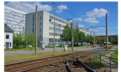
Die alte Haltestelle Gehrenseestraße wird aufgegeben. Die neue Trasse verläuft im Rücken des Fotografen, wo auch die neue Haltestelle Paul-König-Straße entsteht. Die Wendeschleife wird verkleinert und erhält dafür längere Aufstellgleise (mit 60 statt 40 Metern). (Foto: Michael Dittrich)
