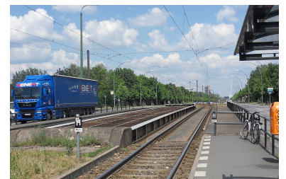
Die Leitungstrasse in der Mitte der Rhinstraßenbrücke verschwindet beim Neubau. So entsteht Platz für direkte Abgänge von den Haltestellen zum unter der Brücke liegenden S-Bahnsteig. (Foto: Tom Gerlich)
