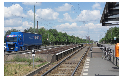
Die Leitungstrasse in der Mitte der Rhinstraßenbrücke verschwindet beim Neubau. So entsteht Platz für direkte Abgänge von den Haltestellen zum unter der Brücke liegenden S-Bahnsteig. (Foto: Tom Gerlich)
