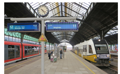
Unverständlich: Während der polnische Abschnitt Wegliniec--Zgorzelec bis voraussichtlich Ende 2020 elektrifiziert sein wird, verharren die für den Lückenschluss auf deutscher Seite notwendigen Elektrifizierungsprojekte Dresden--Görlitz und Cottbus--Görlitz lediglich im »Potenziellen Bedarf« des Bundesverkehrswegeplans bzw. des Bundesschienenwegeausbaugesetzes. (Foto: Christian Schultz (Bahnhof Görlitz))
