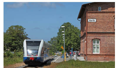
Erst vor wenigen Jahren wurden Strecke und Bahnhof umfangreich erneuert und zukunftsfähig gemacht. Soll nun der Verfall die Zukunft sein? (Foto: BfVst)
