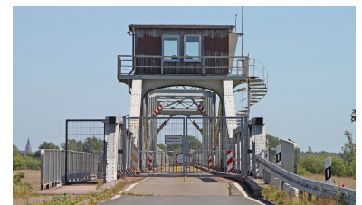
Auch wenn es heute so aussieht: Das ist keine Grenzsicherungsanlage. Die Meiningerbrücke verband einst auch auf Schienenwegen die Insel mit dem Rest der Welt. Die ungünstige Lage der heutigen Straßenbrücke kann eine Wiederinbetriebnahme der Bahn jedoch erschweren. (Foto: BfVst)
