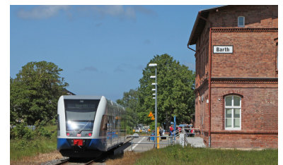
Erst vor wenigen Jahren wurden Strecke und Bahnhof umfangreich erneuert und zukunftsfähig gemacht. Soll nun der Verfall die Zukunft sein? (Foto: BfVst)
