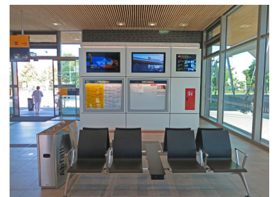
Der Wartebereich des Empfangsgebäudes von Lutherstadt Wittenberg Hauptbahnhof ist einladend, hell und freundlich gestaltet. Auf einem der Monitore werden auch die aktuelle Leistung, der Tages- und Gesamtertrag der Photovoltaikanlage angezeigt. (Foto: Christian Schultz)
