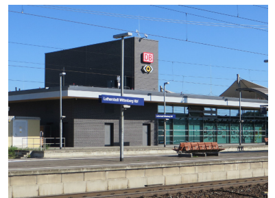
Lutherstadt Wittenberg Hauptbahnhof: Auf dem Gründach des Empfangsgebäudes ist eine Photovoltaikanlage mit einer Fläche von 120 m 2 bzw. einer Leistung von 20 500 kWh/Jahr installiert. (Foto: Christian Schultz)
