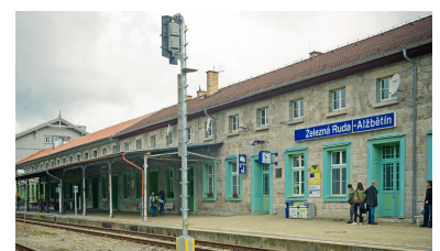
Dass die Deutsche Bahn das beeindruckende Empfangsgebäude des Bahnhofs Bayerisch Eisenstein an den »Naturpark Bayerischer Wald e. V.« verkauft hat, ist ein Glücksfall. Heute sind in dem umfassend sanierten Empfangsgebäude u. a. mehrere Museen untergebracht. (Foto: Allianz pro Schiene, Andreas Taubert)
