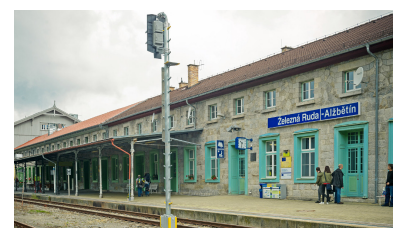
Dass die Deutsche Bahn das beeindruckende Empfangsgebäude des Bahnhofs Bayerisch Eisenstein an den »Naturpark Bayerischer Wald e. V.« verkauft hat, ist ein Glücksfall. Heute sind in dem umfassend sanierten Empfangsgebäude u. a. mehrere Museen untergebracht. (Foto: Allianz pro Schiene, Andreas Taubert)
