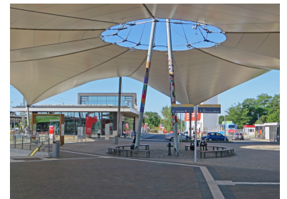
Am 9. Dez. 2016 wurde das neue Empfangsgebäude von Lutherstadt Wittenberg Hauptbahnhof eröffnet. Es ist der zweite »grüne Bahnhof« in Deutschland. Das Zeltdach auf dem großzügigen Vorplatz bietet umfassenden Witterungsschutz. (Foto: Christian Schultz)
