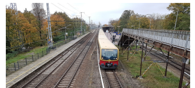
Bahnhof Karlshorst. Ab dem Fahrplanwechsel am 10. Dezember 2017 hält hier nur noch die S 3. Trotz vielfältiger Bemühungen des Bezirks Lichtenberg und der Anwohner wird der Halt der Regionalzuglinien RE 7 und RB 14 entfallen. 2018 werden die Regionalbahnsteige (im Foto links und rechts des S-Bahn-Zuges) abgebrochen. (Foto: Marc Heller)
