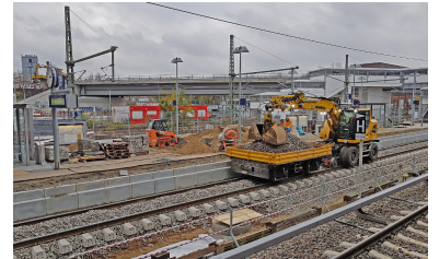
Letzte Bauarbeiten am neuen Regionalbahnsteig in Ostkreuz. Nachdem hier bis August die Züge der S 3 endeten, wird der Bahnsteig nun für den Regionalverkehr umgebaut. Sehr ärgerlich ist, dass die hier geplante Bahnsteigüberdachung nicht gebaut wird. Es ist leider nicht das erste Mal, dass die Deutsche Bahn ihre Fahrgäste im wörtlichen Sinn im Regen stehen lässt. (Foto: Marc Heller)
