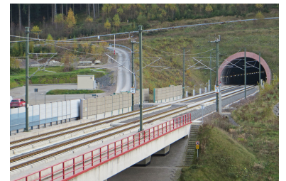
Für die aufwändige Trassierung des 107 km langen Abschnitts Erfurt--Ebensfeld auf der Hochgeschwindigkeitsstrecke Berlin--München waren 22 Tunnel (Gesamtlänge 41 Kilometer) und 29 Talbrücken (Gesamtlänge 12 Kilometer) erforderlich. Die derzeit geplante Nutzung ist dagegen (noch?) bescheiden. (Foto: Christian Schultz)
