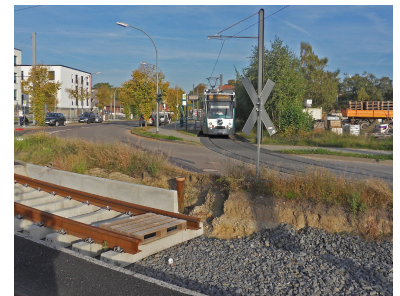
Die Wendeschleife Viereckremise (mit Zug) wird aufgegeben und das Grundstück soll bebaut werden. Von links kommend wartet das Gleis der Neubaustrecke auf den Anschluss. (Foto: Fotograf)
