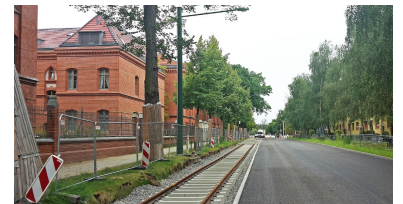
Neben der B2 ist die neue Strecke auf 300 Meter Länge zwar nur eingleisig, aber stauunabhängig. Links im Bild die »Roten Kasernen«, die seit einigen Jahren Wohnzwecken dienen. (Foto: Florian Müller)
