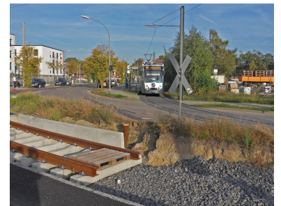
Die Wendeschleife Viereckremise (mit Zug) wird aufgegeben und das Grundstück soll bebaut werden. Von links kommend wartet das Gleis der Neubaustrecke auf den Anschluss. (Foto: Fotograf)
