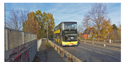
Die marode Sellheimbrücke wird von den Buslinien 150 und 158 befahren. Die Linie 350 könnte hier her verlängert werden. Die Verlängerung der S 75 wurde zwar begonnen, aber Anfang der 90er Jahre abgebrochen. Heute fehlt diese Querverbindung, die mit dem Turmbahnhof Karower Kreuz einen sinnvollen Verknüpfungspunkt hätte. Bis zur Verlängerung der S-Bahn sollte hier schnellstmöglich ein provisorischer Regionalbahnhof für die Linien RB 12 und RB 24 errichtet werden, um den bau- und staugeplagten Nordosten zu entlasten. (Foto: Tom Gerlich)
