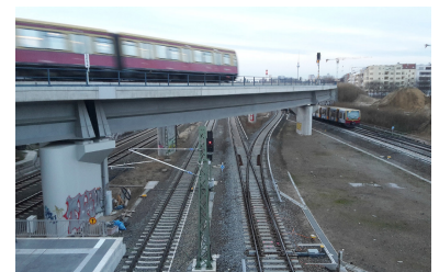
Ebenfalls zum Fahrplanwechsel ging am Ostkreuz die wiederaufgebaute Südringkurve für die S 9 in Betrieb und bringt das in den letzten Jahren gewohnte Liniengefüge »durcheinander«. Regelmäßige 8-Minuten-Lücken zwischen Warschauer Str. und Ostkreuz, Ausdünnung auf dem Osttring, aufgegebene Anschlussbeziehungen uvm. (Foto: Florian Müller)
