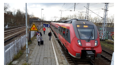
Keine Eröffnung, sondern eine Schließung brachte der Fahrplanwechsel für den Regionalbahnhof Berlin-Karlshorst. Die beiden Bahnsteige sind baufällig und nicht barrierefrei erreichbar, so dass ein aufwändiger Neubau fällig wäre. Fahrgäste werden auf den neuen Regionalbahnhalt am benachbarten Ostkreuz verwiesen, der allerdings im Tarifbereich A liegt. Die IGEB bedauert die Aufgabe des R-Bf Karlshorst, da damit die wichtige
