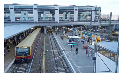
Der Regionalbahnsteig »Ru« Ostkreuz Gleis 1 und 2 ging zum 10. Dezember 2017 in Betrieb. Damit steigt die Bedeutung von Ostkreuz als wichtigster Bahnhof Berlins weiter. Nicht hinnehmbar ist, dass bei diesem Bahnsteig das planfestgestellte Dach nicht gebaut wurde. Hier halten die RE 1, RE 2, RE 7 und RB 14. Der Halt des RE 2 am Ostbahnhof wurde dafür wegen »Fahrplanzwängen« leider aufgegeben. (Foto: Florian Müller)
