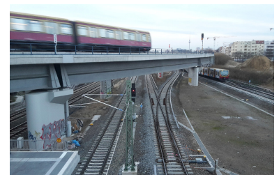
Ebenfalls zum Fahrplanwechsel ging am Ostkreuz die wiederaufgebaute Südringkurve für die S 9 in Betrieb und bringt das in den letzten Jahren gewohnte Liniengefüge »durcheinander«. Regelmäßige 8-Minuten-Lücken zwischen Warschauer Str. und Ostkreuz, Ausdünnung auf dem Ostring, aufgegebene Anschlussbeziehungen uvm. (Foto: Florian Müller)
