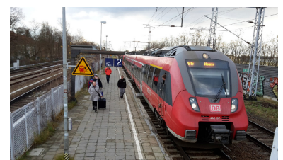
Keine Eröffnung, sondern eine Schließung brachte der Fahrplanwechsel für den Regionalbahnhof Berlin-Karlshorst. Die beiden Bahnsteige sind baufällig und nicht barrierefrei erreichbar, so dass ein aufwändiger Neubau fällig wäre. Fahrgäste werden auf den neuen Regionalbahnhalt am benachbarten Ostkreuz verwiesen, der allerdings im Tarifbereich A liegt. Die IGEB bedauert die Aufgabe des R-Bf Karlshorst, da damit die wichtige
