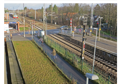
Bahnhof Blankenfelde: Geplant ist der Neubau
