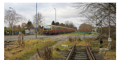
Der Bahnübergang Sântisstraße wird im April 2018 gesperrt. Als Ersatz wird bis Ende März 2018 eine provisorische Fußgängerüberführung errichtet. Vorab wurden in diesem Bereich bereits Reptilienschutzzäune installiert. (Foto: Christian Schultz)
