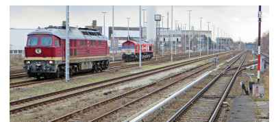
Im Rahmen des Ausbaus der Dresdener Bahn werden die Güterverkehrsanlagen des Bahnhofs Marienfelde deutlich reduziert. Selbst die beiden verbleibenden Ausweichgleise werden nicht mit einer Nutzlänge von 750 Metern realisiert, sondern lediglich mit rund 450 Metern. (Foto: Christian Schultz)
