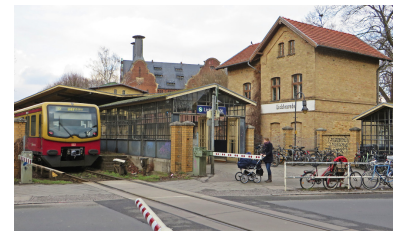
Im Zuge des Ausbaus der Dresdener Bahn können das ehemalige Empfangsgebäude des Bahnhofs Lichtenrade, die Zugangsbauwerke und der heutige Mittelbahnsteig nicht erhalten werden, obwohl es denkmalgeschützte Bauten sind. (Foto: Christian Schultz)
