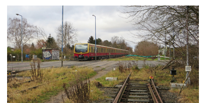
Der Bahnübergang Säntisstraße wird im April 2018 gesperrt. Als Ersatz wird bis Ende März 2018 eine provisorische Fußgängerüberführung errichtet. Vorab wurden in diesem Bereich bereits Reptilienschutzzäune installiert. (Foto: Christian Schultz)
