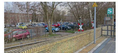
Nicht entbehrlich sind der Südzugang des S-Bahn-Haltepunkts Buckower Chaussee und der gut genutzte P+R-Parkplatz. Mit diesem Zugang wird ein kurzer Weg zur S-Bahn insbesondere für die Anwohner des Wohngebiets Dörfelweg/Kettinger Straße gewährleistet. (Foto: Christian Schultz)
