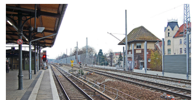
Die Modernisierung der Frankfurter Bahn führt dazu, dass auch sie über weite Strecken zwischen Lärmschutzwänden verschwindet - an die Stelle der akustischen Belästigung tritt die optische. Am Bahnhof Friedrichshagen wurde auf diese Weise auch das alte Stellwerk von den Bahnanlagen getrennt (Aufnahme vom November 2016). (Foto: Jan Gypmel)
