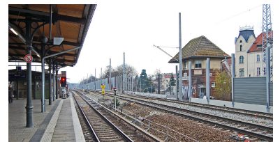
Die Modernisierung der Frankfurter Bahn führt dazu, dass auch sie über weite Strecken zwischen Lärmschutzwänden verschwindet - an die Stelle der akustischen Belästigung tritt die optische. Am Bahnhof Friedrichshagen wurde auf diese Weise auch das alte Stellwerk von den Bahnanlagen getrennt (Aufnahme vom November 2016). (Foto: Jan Gypmel)
