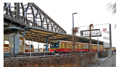
Die Station Betriebsbahnhof Rummelsburg befindet sich zum Teil unter der Brücke der VnK-Strecke, die die Ostbahn mit der Frankfurter Bahn verband. Deren Rangierbahnhof, entstanden im Zusammenhang mit der Ringbahn, wurde hier ab 1879 betrieben. Heute wird das Areal weitgehend durch den 1914 eröffneten Abstellbahnhof benutzt, auf dem Reisezüge auch behandelt werden. (Foto: Jan Gypmel)
