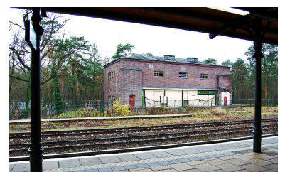
1928 begann der elektrische Betrieb auf den Vorortgleisen der Frankfurter Bahn bis Erkner. Dafür entstand auch das Gleichrichterwerk Rahnsdorf, ein typischer Bau des Reichsbahn-Architekten Richard Brademann. (Foto: Jan Gypmel)
