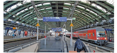
Großer Bahnhof: Die nördliche Halle des Berliner Ostbahnhofs. Doch nur fünf Bahnsteiggleise der 1842 als Frankfurter Bahnhof eröffneten Station dienen dem Regional- und Fernverkehr. (Foto: Marc Heller)
