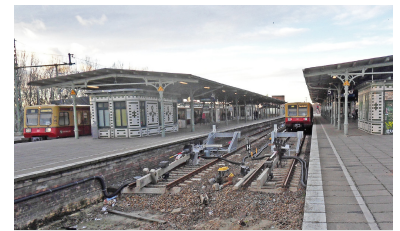
Der Bahnhof Schöneeweide bleibt auch nach Fertigstellung der Sternsüdbrücken noch jahrelang eine Baustelle, denn im Anschluss werden der Personentunnel saniert und die neue Unterführung für die Straßenbahn gebaut. Damit bleibt der Bahnhof auch in der Fahrplanplanung ein Nadelöhr, das nun durch die S 9 auch mit der Stadtbahn verknüpft ist. (Foto: Tom Gerlich)
