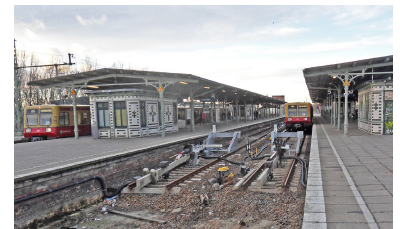
Der Bahnhof Schöneeweide bleibt auch nach Fertigstellung der Sternдамbrücken noch jahrelang eine Baustelle, denn im Anschluss werden der Personentunnel saniert und die neue Unterführung für die Straßenbahn gebaut. Damit bleibt der Bahnhof auch in der Fahrplanplanung ein Nadelöhr, das nun durch die S 9 auch mit der Stadtbahn verknüpft ist. (Foto: Tom Gerlich)
