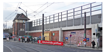
Der neue Zugang zum S-Bahnhof Friedrichshagen (rechts hinter dem roten Banner) wird hoffentlich demnächst eröffnet. Umsteiger zur Straßenbahn müssen allerdings weiterhin lange auf die kurze Grünphase warten. Ausgerechnet die Haltestelle am S-Bahnhof wurde wegen offener Streitigkeiten nicht barrierefrei umgebaut. (Foto: Tom Gerlich)
