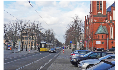
Anarchie am Marktplatz Friedrichshagen: Die haltende Straßenbahn wird wie befürchtet links überholt. Die Straße wurde in den letzten 3 Monaten nicht einmal behelfsmäßig markiert. Anstelle des eigenen Bahnkörpers südlich vom Marktplatz wird nun auf der alten Fahrspur illegal quer geparkt. (Foto: Tom Gerlich)
