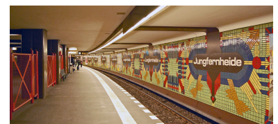
Vergangenes Jahr wurden alle 1984 eröffneten U 7-Stationen von Paulsternstraße bis Rathaus Spandau unter Denkmalschutz gestellt, vom anschließenden, bereits 1980 in Betrieb gegangenen Abschnitt jedoch nur die Bahnhöfe Rohrdamm und Siemensdamm. Dabei ist letzterer bereits stark verändert worden. Weitgehend im Originalzustand erhalten, doch noch immer schutzlos sind hingegen die Stationen Jungfernhöhe und Mierendorffplatz (ebenfalls 1980 eröffnet) sowie Richard-Wagner-Platz und Konstanzer Straße (1978 eröffnet). Die zwischen all diesen U-Bahnhöfen liegenden Stationen Halemweg, Jakob-Kaiser-Platz, Bismarckstraße, Wilmersdorfer Straße und Adenauerplatz wurden von der BVG bereits stark verändert oder ihre Umgestaltung ist (zum Teil seit Jahren) im Gange. (Foto: Jan Gympel)
