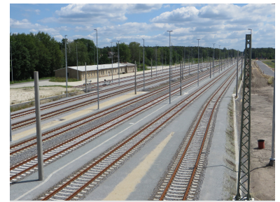
Nach dem Ausbau der Strecke Knappenrode–Horka–Grenze Deutschland/Polen, Teil des europäischen Bahnnetzes zwischen Nordsee und Polen, können in dieser Relation Güterzüge mit einer Gesamtlänge bis zu 740 Metern verkehren. (Foto: Christian Schultz (Horka Güterbahnhof))
