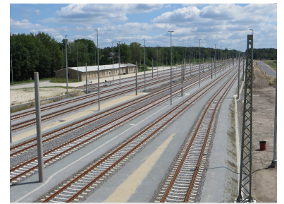
Nach dem Ausbau der Strecke Knappenrode–Horka–Grenze Deutschland/Polen, Teil des europäischen Bahnnetzes zwischen Nordsee und Polen, können in dieser Relation Güterzüge mit einer Gesamtlänge bis zu 740 Metern verkehren. (Foto: Christian Schultz (Horka Güterbahnhof))
