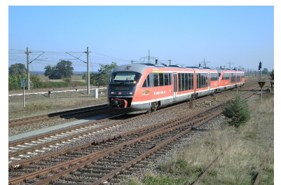
Die Stammstrecke der Lehrter Bahn zeigt das Dilemma: Auch der Bahnhof Schönhausen (Elbe) verfügt zwar bereits über Überholgleise für 740 Meter lange Güterzüge, »eingespart« wurde aber die Elektrifizierung. Die Umsetzung dieses Projekts bleibt damit bislang »Flickwerk«. (Foto: Christian Schultz)
