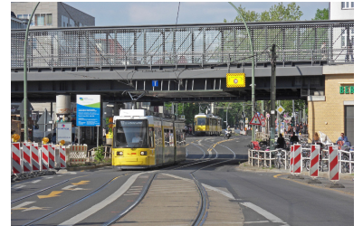
Im aktuellen Bauzustand wird die Verschwenkung der Straßenbahn schon mal getestet. An bis zu 4 der 5 Baustellenampeln wird sie ausgebremst, so auch mit jeder Fahrt nordwärts unter der Brücke - quasi als »Probehalt« für die künftige Haltestelle. Auch künftig muss sich die Straßenbahn hier eine Spur mit den Autos teilen. (Foto: Tom Gerlich)
