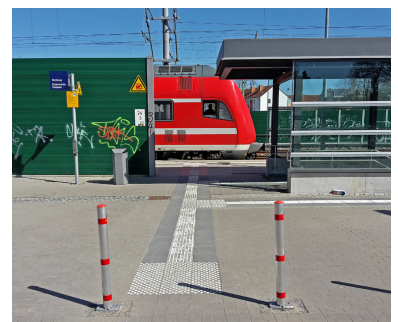
»Zweckmäßig und funktional« würden Planer den Bahnsteigzugang in Rangsdorf beschreiben. Praktisch handelt es sich lediglich um ein Loch in der Lärmschutzwand mit der Schallquelle zugewandter Wartefläche unter freiem Himmel - also ohne Bahnsteigdach. (Foto: Florian Müller)
