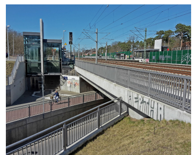
Am Bahnhof Rangsdorf wurde kürzlich der Bahnübergang durch einen Straßentunnel ersetzt. Die Fläche des alten S-Bahnsteigs befindet sich hinter dem Aufzug. Heute halten hier Regionalzüge. Die Fernzüge nach Dresden fahren auf den mittleren Gleisen durch. (Foto: Florian Müller)
