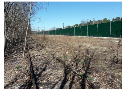
Bis 1961 fuhr die Berliner S-Bahn schon nach Rangsdorf. Die Fläche des alten S-Bahnsteigs wurde auch beim Ausbau der Fernbahn (hinter der Schallschutzwand) freigelassen, und das rostige Gleis liegt noch in der Lage des Bahnsteiggleises. (Foto: Florian Müller)
