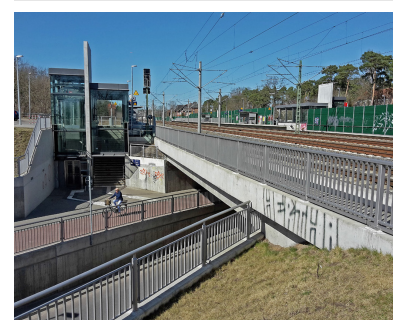
Am Bahnhof Rangsdorf wurde kürzlich der Bahnübergang durch einen Straßentunnel ersetzt. Die Fläche des alten S-Bahnsteigs befindet sich hinter dem Aufzug. Heute halten hier Regionalzüge. Die Fernzüge nach Dresden fahren auf den mittleren Gleisen durch. (Foto: Florian Müller)
