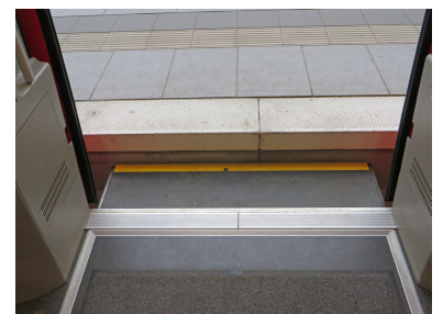
Leipzig Hauptbahnhof. Wäre hier die Bahnsteighöhe mit 0,55 Meter ausgeführt, wäre die gesetzlich geforderte Barrierefreiheit beim Talent 2 gegeben! (Foto: Christian Schultz)
