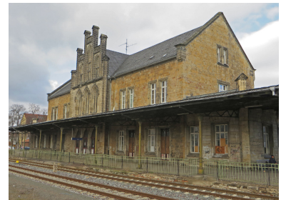
Bahnhof Quedlinburg. Der Koalitionsvertrag sieht erfreulicherweise ein »1000-Bahnhöfe«-Förderprogramm vor. Wie dringlich das ist, verdeutlicht das abschreckende Erscheinungsbild vieler Bahnhöfe. Selbst der Bahnhof in der Welterbestadt Quedlinburg zählt dazu, wie sowohl Teile des Empfangsgebäudes ... (Foto: Christian Schultz)
