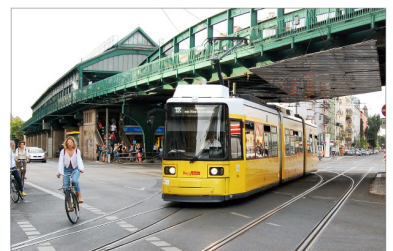
Die Unfähigkeit, ein großes, langes, strahlend weiß und leuchtend gelb lackiertes Schienenfahrzeug, welches auf einen zukommt, wahrzunehmen, ist noch lange kein Grund, nicht am Straßenverkehr teilzunehmen (oder zumindest belebte, etwas unübersichtliche Kreuzungen zu meiden). Diese wackere Radlerin rollte jedenfalls schnurstracks auf eine Kollision mit dem Zug zu - bis sie sich nach mehrmaligem Warnsignal doch zu einem Stopp bewegen ließ (wobei sich ihr Vorderrad schon fast im Lichtraumprofil der Tram befand). (Fotos: Jan Gympel)
