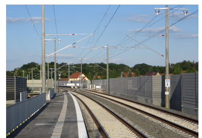
Künftiger Haltepunkt Hyust zwischen Hoyerswerda und Horka. Am 9. Dezember 2018 soll der Regelbetrieb auf der Ausbaustrecke Knappenrode--Horka im Personen- und Güterverkehr beginnen. Bei Führung der Züge über den Laufweg Berlin--Cottbus--Senftenberg--Hoyerswerda--Breslau besteht dann die Möglichkeit, die Züge nach Polen deutlich zu beschleunigen. (Foto: Christian Schultz)
