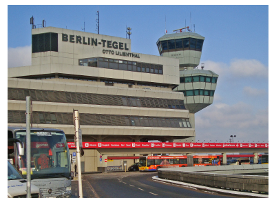
Flughafen Tegel. Nach der zurzeit für Ende 2020 geplanten Schließung soll hier ein neuer Stadtteil mit dem Arbeitstitel »Urban Tech Republic« entstehen. Die Größe des Geländes legt eine Erschließung mit der Straßenbahn nahe. Dennoch soll nun auch eine U-Bahn-Anbindung untersucht werden, allerdings nicht, wie einst geplant, durch Verlängerung der U 5 von Moabit, sondern durch einen Abzweig von der U 6 Nord. (Foto: Florian Müller (2015))
