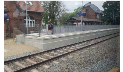
Der modernisierte Bahnsteig in Blumberg hat nur noch eine Bahnsteigkante an den zwei Gleisen, anstatt bisher zwei - hier gesehen aus einem durchfahrenden Sonderzug. Damit sind zwar Zugkreuzungen im Verspätungsfall möglich, aber kein Fahrgastwechsel. Auch für einen 30-Minuten-Takt ist eine zweite Bahnsteigkante erforderlich. (Foto: Florian Müller)
