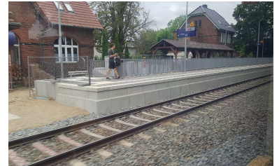
Der modernisierte Bahnsteig in Blumberg hat nur noch eine Bahnsteigkante an den zwei Gleisen, anstatt bisher zwei - hier gesehen aus einem durchfahrenden Sonderzug. Damit sind zwar Zugkreuzungen im Verspätungsfall möglich, aber kein Fahrgastwechsel. Auch für einen 30-Minuten-Takt ist eine zweite Bahnsteigkante erforderlich. (Foto: Florian Müller)
