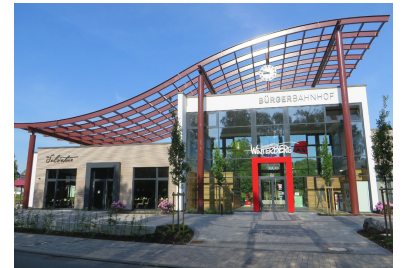
Ähnlich wie in Eppstein wurde auch im Bahnhof Winterberg in Nordrhein-Westfalen ein für Bürger und Gäste der Stadt attraktives, vielseitiges Nutzungskonzept umgesetzt. Beim Neubau des Empfangsgebäudes haben Stadt und Architekt bewusst markante Akzente gesetzt und so für einen hohen Wiedererkennungswert gesorgt. (Foto: Christian Schultz)
