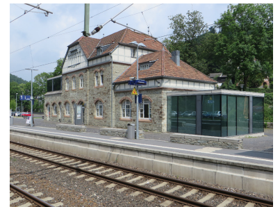
Außen wie innen vorbildlich saniert: Das Empfangsgebäude des Bahnhofs Eppstein in Hessen. Der Bahnhof ist seitdem zu einer zentralen und attraktiven Anlaufstelle für Bürger, Pendler und Ausflügler geworden. (Foto: Christian Schultz)
