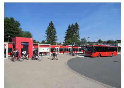
Auch in Winterberg wurden im Rahmen der Neugestaltung des Bahnhofs u. a. kurze Umsteigewege zwischen Zug und Bus realisiert. (Foto: Christian Schultz)
