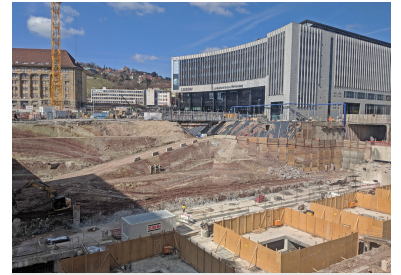
Baugrube für das Bahnhofprojekt Stuttgart 21. Dieses Projekt hat mit seinen steigenden Kosten inzwischen einen zweifelhaften Spitzenplatz erreicht. Der Europäische Rechnungshof schreibt dazu: »Infrastruktur für Hochgeschwindigkeitsstrecken ist teuer: Im Durchschnitt kosteten die geprüften Strecken 25 Millionen Euro pro km. Bei vier der zehn geprüften Strecken werden sich pro eingesparter Minute Fahrzeit Kosten von mehr als 100 Millionen Euro ergeben. Am höchsten fällt dieser Wert für die Strecke Stuttgart-München aus, wo sich die Kosten pro eingesparter Minute auf 369 Millionen Euro belaufen werden.« Dem ist nichts mehr hinzuzufügen. (Foto: IGEB/hm)
