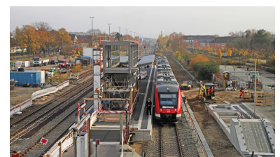
Der Bahnhof Velten wird zurzeit umfangreich umgebaut - aber noch ohne S-Bahn. Links ist die Fläche für einen späteren S-Bahnsteig freigehalten. (Foto: BfVst)
