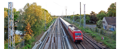
Der Berliner Außenring wurde in den 50er Jahren fertiggestellt zur Umgehung West-Berlins. Sein Südabschnitt galt als eine der am stärksten befahrenen Strecken der DDR und wurde noch in den 80ern teilweise vierspurig ausgebaut. Für den heutigen Verkehr ist dies überdimensioniert. Westlich des Bahnhofs Flughafen Schönefeld wurde ein Gleispaar inzwischen von der S-Bahn zum neuen Großflughafen BER übernommen und statt mit Oberleitung mit Stromschienen versehen. (Foto: Jan Gympel)
