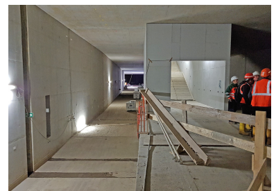
Das Nordende des Bahnsteigs mit Blick in den Gleisstroß Richtung Wedding. Der Treppenzugang wird für die Verlängerung Richtung Potsdamer Platz wieder abgerissen. (Foto: Florian Müller, Oktober/November 2018)
