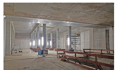
Das Zwischengeschoss über dem provisorischen Bahnsteig, Blickrichtung Süd. Rechts hinter der Wand befindet sich die Passarelle der U 55, zu der es Durchgänge geben wird. Die Treppe rechts führt hinab zum Südende des provisorischen Bahnsteigs. (Foto: Florian Müller, Oktober/November 2018)
