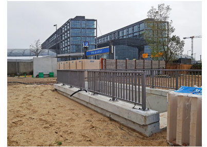
Der Zugang zum provisorischen S21-Bahnhof nördlich der Invalidenstraße ist noch hinter Bauzäunen versteckt. Er befindet sich in der Nähe des U-Bahn-Eingangs. (Foto: Florian Müller)
