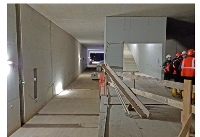
Das Nordende des Bahnsteigs mit Blick in den Gleisstroß Richtung Wedding. Der Treppenzugang wird für die Verlängerung Richtung Potsdamer Platz wieder abgerissen. (Foto: Florian Müller, Oktober/November 2018)
