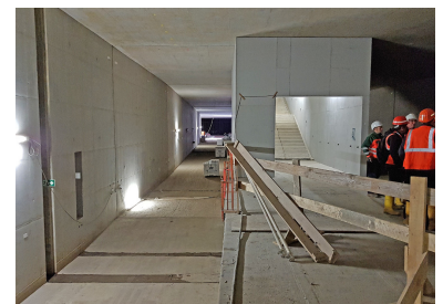
Das Nordende des Bahnsteigs mit Blick in den Gleisstroß Richtung Wedding. Der Treppenzugang wird für die Verlängerung Richtung Potsdamer Platz wieder abgerissen. (Foto: Florian Müller, Oktober/November 2018)
