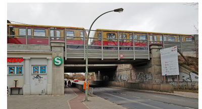
Schallschutzwände kann man auch transparent bauen, so wie hier in Berlin-Blankenburg. Die in Lichtenrade geplanten drei parallelen Wände (s. Visualisierung rechts) sind eine optische Katastrophe. Allerdings ist die Dämmwirkung damit deutlich besser als bei Glas. (Foto: Florian Müller, Dez. 2018)
