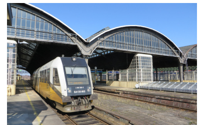
Unverständlich: Einerseits wird auf polnischer Seite die Strecke Wegliniec--Zgorzelec bis Ende 2019 elektrifiziert, andererseits wird auf deutscher Seite die Schließung der Elektrifizierungslücken ab Grenze Deutschland/Polen seit Jahren verschleppt. Dies gilt selbst für die fehlenden rund 1000 Meter zwischen den Bahnhöfen Zgorzelec und Görlitz (im Bild). (Foto: Christian Schultz)
