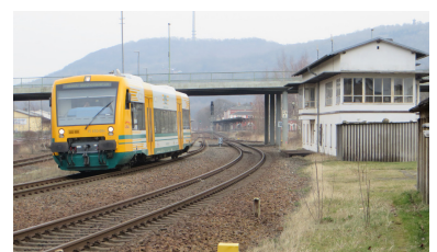
Bahnhof Löbau (Sachs). Auch die Strecke Dresden--Löbau--Görlitz--Grenze D/PL erfüllt nicht die Kriterien für die Aufnahme in den Vordringlichen Bedarf des Bedarfsplans im Bundesschienenwegeausbaugesetz. Geplant ist nun, die Elektrifizierung im Rahmen des angekündigten Sonderprogrammes des Bundes zu realisieren. (Foto: Christian Schultz)
