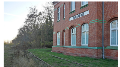
Ob hier in Rangsdorf am alten Empfangsgebäude der ehemaligen Militäreisenbahn jemals wieder eine S-Bahn vorbei kommt? Die Chancen sind deutlich gestiegen, seitdem sich Brandenburgs Ministerpräsident Dietmar Woidke am 8. Juni 2018 öffentlich für die S-Bahn-Verlängerung von Blankenfelde nach Rangsdorf ausgesprochen hat. (Foto: BfVst)
