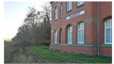
Ob hier in Rangsdorf am alten Empfangsgebäude der ehemaligen Militäreisenbahn jemals wieder eine S-Bahn vorbei kommt? Die Chancen sind deutlich gestiegen, seitdem sich Brandenburgs Ministerpräsident Dietmar Woidke am 8. Juni 2018 öffentlich für die S-Bahn-Verlängerung von Blankenfelde nach Rangsdorf ausgesprochen hat. (Foto: BfVst)
