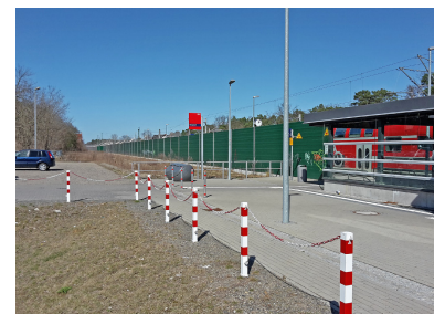
Regionalbahnhof Rangsdorf. Rechts hinter der grünen Schallschutzwand befindet sich der modernisierte Regionalbahnhof, links davon auf der Freifläche befand sich der S-Bahnhof - wo er auch wieder aufgebaut werden könnte. (Foto: Florian Müller)
