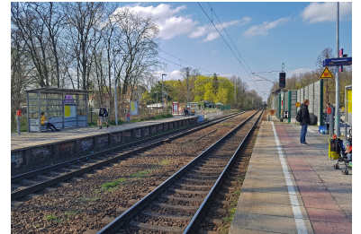
Der Regionalbahnhof Dahlewitz ist noch nicht modernisiert - das war bisher im Ausbauprojekt der Dresdener Bahn, Abschnitt Blankenfelde--Rangsdorf, bis frühestens 2027 geplant. Beim Bau einer S-Bahn mit Halt in Dahlewitz (auf dem Bild links der Fern-/Regiogleise) und Aufgabe des Regionalbahnhofs würde die ganze Anlage komplett umgebaut werden. (Foto: Florian Müller)
