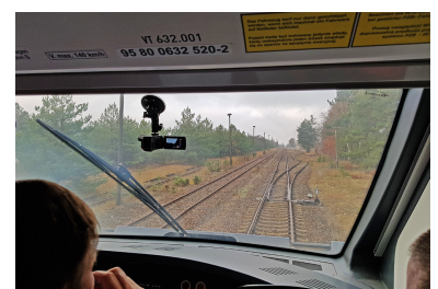
Blick auf die ehemals noch viel umfangreicheren Gleisanlagen in Milmersdorf. Hier finde noch Holzverladung auf Güterzüge statt. (Foto: Florian Müller)
