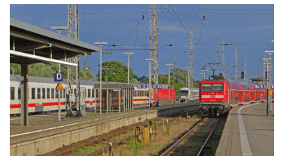
Stralsund Hbf ist künftig besser erreichbar, denn der Ausbau der Strecke Berlin--Angermünde--Stralsund für eine Höchstgeschwindigkeit von 160 km/h ist nun endlich in den »Vordringlichen Bedarf« eingestuft. (Foto: Christian Schultz)
