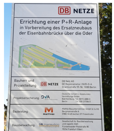
Zu den vorbereitenden Arbeiten für die Brücken-Neubauten über Odervorflut bzw. Oder und der damit verbundenen Streckensperrung gehört auch der Neubau eines Park+Ride-Platzes am Bahnhof Küstrin-Kietz. (Foto: Christian Schultz)
