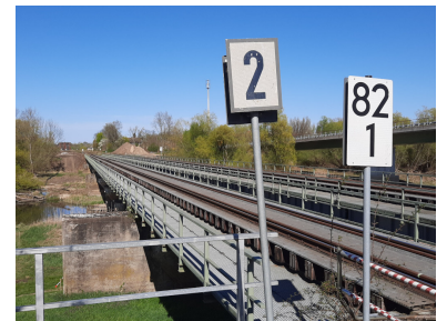
Ab Dezember 2020 beginnt der dringend notwendige Ersatzneubau der Brücken über die Odervorflut (hier im Bild) und die Oder. Zu den vorbereitenden Arbeiten gehört u. a. die bereits laufende Kampfmittelräumung. (Foto: Christian Schultz)
