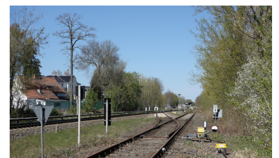
Südlich vom S-Bf Mahlow beginnt künftig das Ausfädelungsbauwerk für die neue Mahlower Kurve für den Flughafenexpress. Die neuen Flügelwände stehen dann so dicht an der benachbarten Straße Berliner Damm, dass nur ein S-Bahn-Gleis dazwischen passt. Ein problemloses Verschieben des Bauwerks um vier Meter hätte für das zweite S-Bahn-Gleis Platz gelassen.
