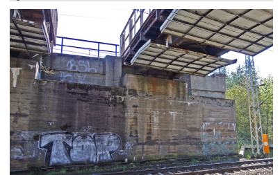
Das Kreuzungsbauwerk der Dresdener Bahn mit dem Berliner Außenring ist für eine Zweigleisigkeit der S-Bahn bereits vorbereitet. Das Bauwerk wird abgerissen und für zwei Fernbahngleise und nur ein S-Bahn-Gleis neu gebaut.
