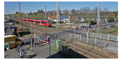
Der Bahnübergang am Bahnhof Blankenfelde wird durch eine Straßenunterführung ersetzt, die nur ein S-Bahn-Gleis berücksichtigen wird. (Foto: André Casper)
