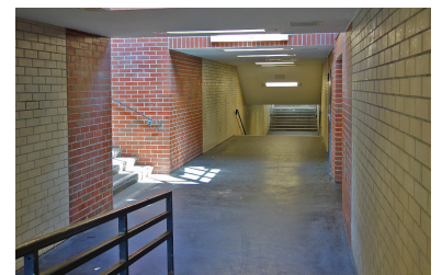
Bahnsteigtunnel S-Bf Mahlow. Vom Bahnsteig (links) zum Empfangsgebäude (hinten) geht es im Tunnel treppab und treppauf, wo die Ferngleise den Tunnel überqueren werden. Diese Schikane wird beim Bau nicht beseitigt, sondern erneut so errichtet. (Foto: André Casper)
