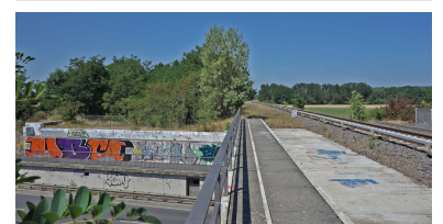
Anfang der 1990er Jahre baute die Reichsbahn bereits weitsichtig die S-Bahn-Brücke über die L76 für zwei Gleise und die Widerlager für vier Gleise.
